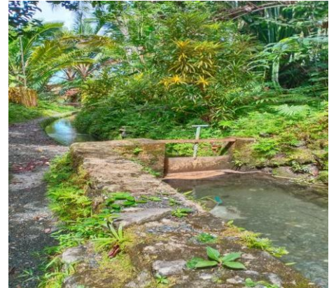
Gambar 3. Saluran Pembawa ( Headrace )
