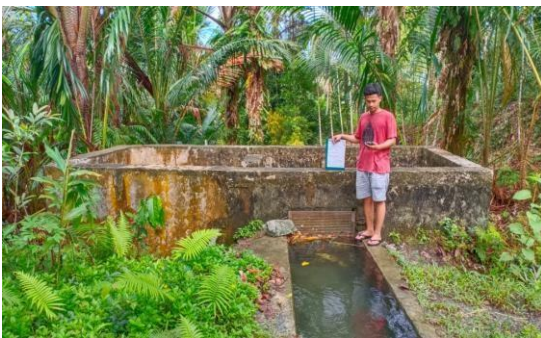
Gambar 5. Bak Penenang ( Forebay )
